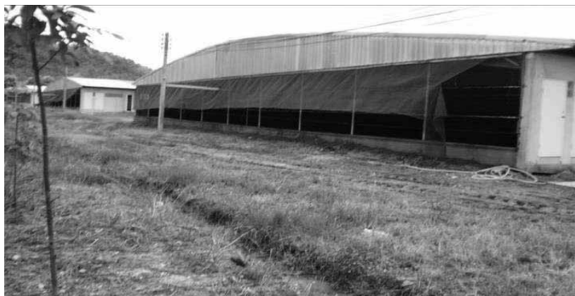
รูปที่ 7.3-21 ภาพถ่ายลักษณะภายนอกโครงสร้างปิดคลุมส่วนท้ายโรงเรือน
