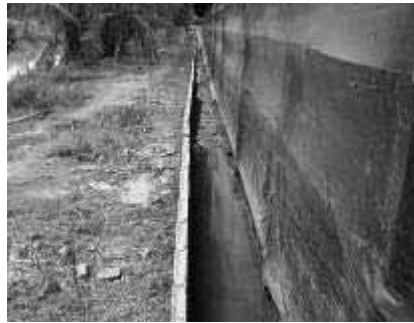
รูปที่ 6.4-7 ลักษณะรางระบายที่มีของเสียดกค้างและรางระบายน้ำที่ไม่มีของเสียดกค้าง
