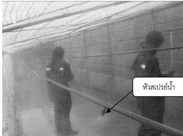
รูปที่ 7.3-12 แสดงลักษณะภายในของระบบกรงกลิ้งมันน้ำกระจายเต็มพื้นที่
