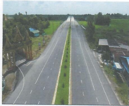
เสาไฟฟ้า
